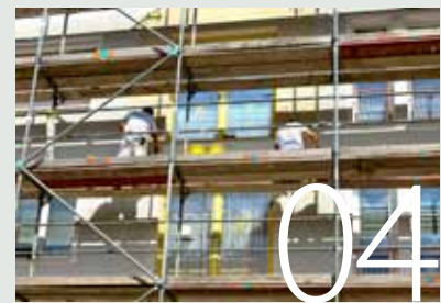
04 Frischer Fassadenanstrich und Balkonanbau in der O.-Damerau-Straße
