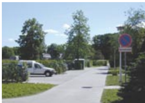
Bereits fertiggestellte Außenanlagen Teschenstr. 4 - 20
