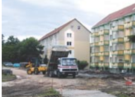
Außenanlagen Am Elsterbogen 51 - 55 derzeit im Bau
