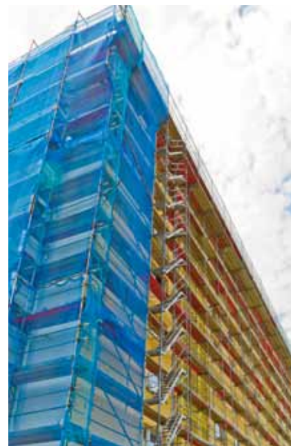
Bauvorhaben Bautzener Allee
