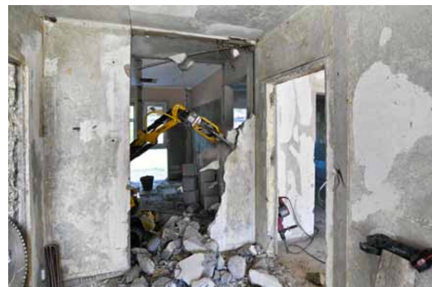
Foto oben: Freigelegtes Ständerwerk im Innenbe- reich, Foto links: Abbruch- arbeiten der Innenwände als Startschuss für zeitge- mäßige Grundrisse
