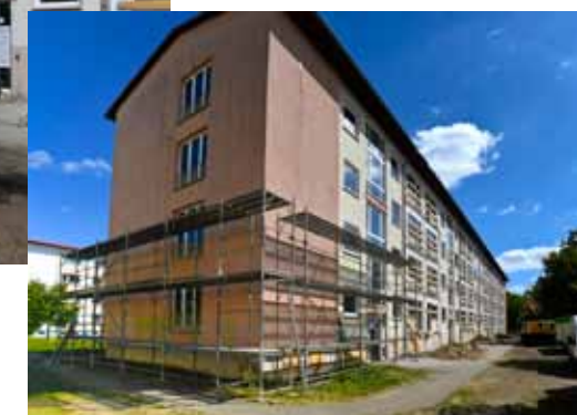
Vorbereitung des Außenbereichs für Wärmedämmung und Balkonanlagen
