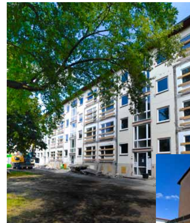
Vorbereitung des Außenbereichs für Wärmedämmung und Balkonanlagen
