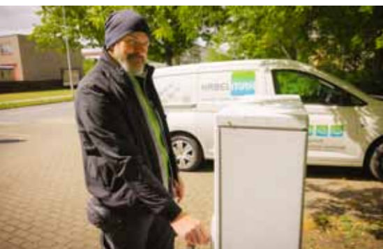
Kabelmax-Techniker André Langner bei der Vorbereitung des Glasfaseranschlusses außerhalb der Wohnung.
